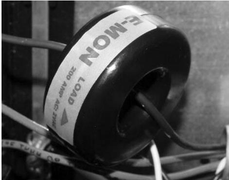
Fig. 6. Sensor de corriente de núcleo sólido.
