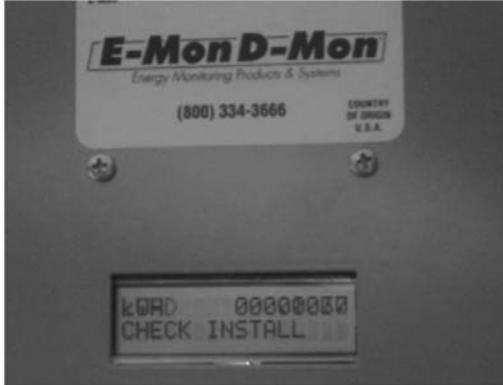
Fig. 27. Error de comprobar instalación.
